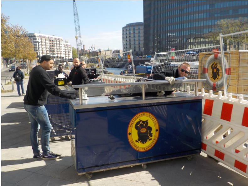
17.04.2019 – Nach der Rückübergabe der Baustelleneinrichtungsflächen wird auf dem Schiffbauer Damm mit dem Wiederaufbau der Biergärten begonnen.
