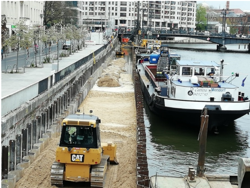
11.04.2019 – Herstellung der temporären Arbeitsebene für das Arbeiten in den Sommermonaten.
